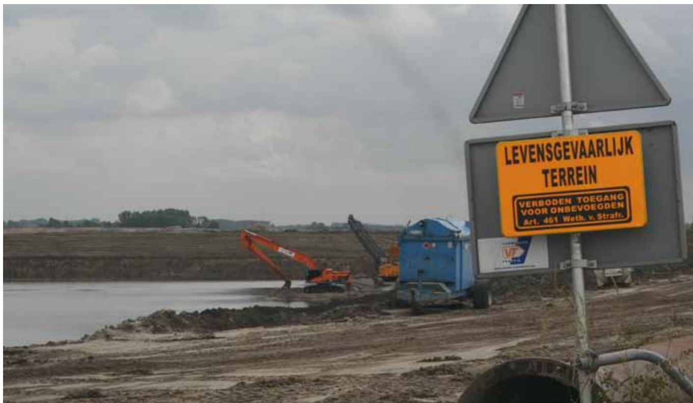
Het weggraven van grond in de Overdiepse Polder.
